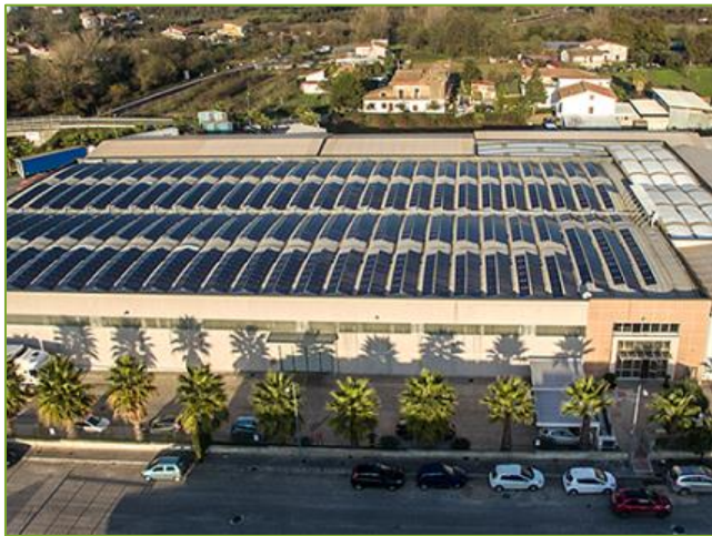
Impianto su tetto con supporti 220 Kw Valle di Maddaloni
